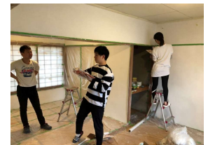
漆喰材の施工
