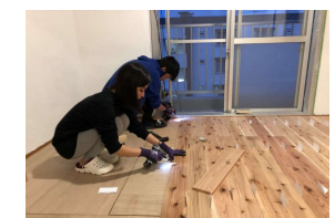
フローリング材の貼り付け
