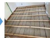
新しい根太を施工
