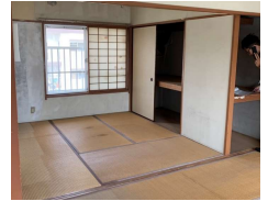
改修前の和室
