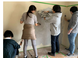
下地材の施工
