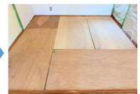
根太の上に合板を施工
