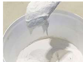
漆喰材の準備
