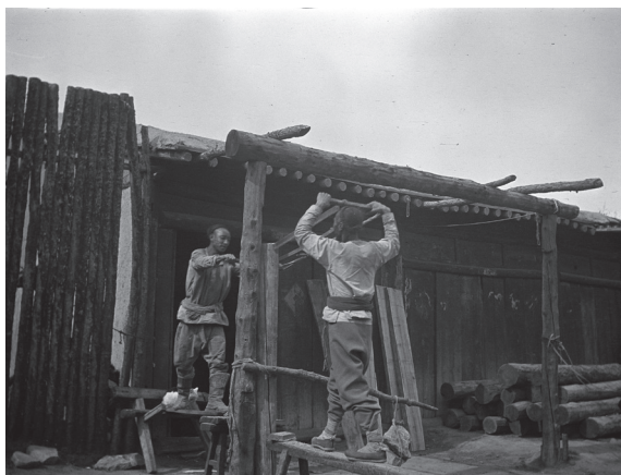
写真 2-15 ウリヤスタイにて、梓鋸を用い丸太から板を挽く中国人大工。1914年7月19日、マーメン撮影、オスロ大学文化史博物館コレクション。UEMf09893_445
