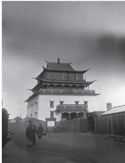
写真 2-3 フレーの弥勒菩薩寺院。垂直な外壁は角丸太造で精度高くつくられている。19-20 世紀、ルシニコフ撮影。(Chuluun and Ivanov 2015: 178, No.1368-55)
