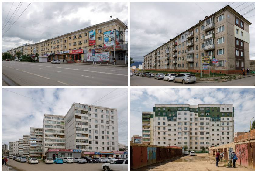
写真 2-28 社会主義時代の計画にもとづいて建設されたアパート。建設年代は左上:1954-61 年、右上:1962-75 年、左下:1976-86 年、右下:1987-2001 年。特に時代が新しいものほど住民が外壁に貼りつけた断熱材の凹凸が目立つ。2019 年 8 月ウランバートルにて八尾廣撮影。
