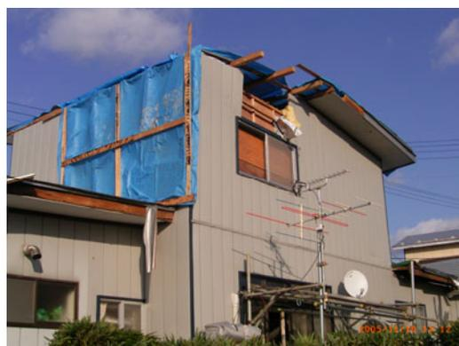
地点6 琴丘町内の被害。壁面，屋根に損傷を受けている。
