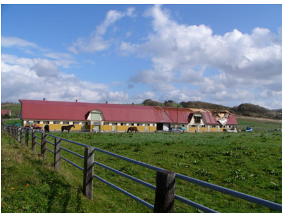
図 16 B 地点の畜舎の被害(A damaged livestock barn)
