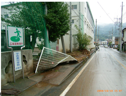
69 伊東市宇佐美 学校フェンス損傷（浸水による）
