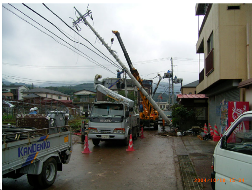
81 伊東市宇佐美 住宅，屋根，窓ガラスの損傷
