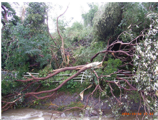
90 伊東市宇佐美 住宅の損傷
