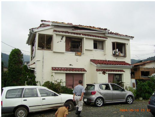
80 伊東市宇佐美 屋根葺き材の飛散
