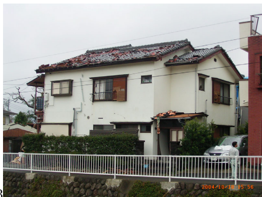
伊東市宇佐美 住宅の屋根瓦の損傷
