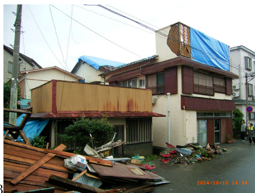
46 伊東市内 ガソリンスタンドの天井の落下
