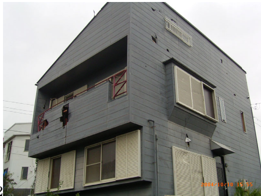
伊東市宇佐美 住宅壁面，飛来物による損傷
