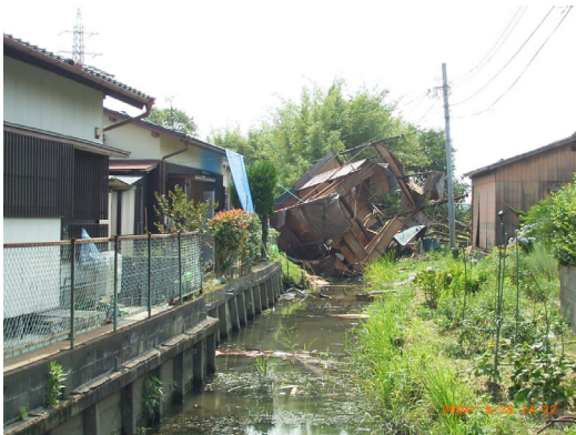
写真5 本願寺周辺，倒壊した仮設小屋
