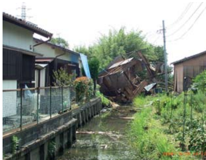
写真4 本願寺周辺、倒壊した 仮設小屋
