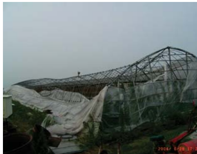
写真5 ビニルハウスの被害
