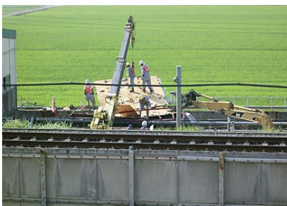
写真1 架線をまたいだ屋根の撤収状況
