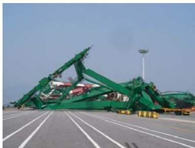
写真1 韓国での強風被害調査(コンテナクレーンの倒壊例)
