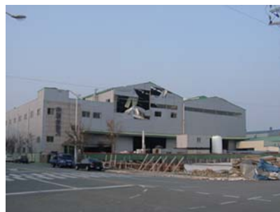
写真5 工場の外装材の被害
