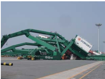
写真1 コンテナクレーンの倒壊
