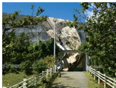
屋根葺材のはがれ
