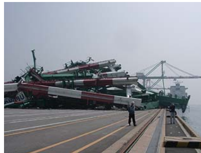
写真2 コンテナクレーンの倒壊
