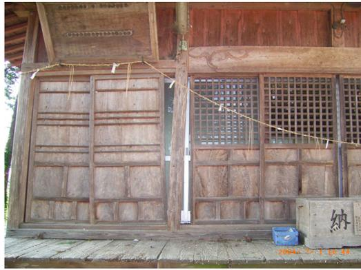
写真5 御霊神社倒木による骨組の傾斜
