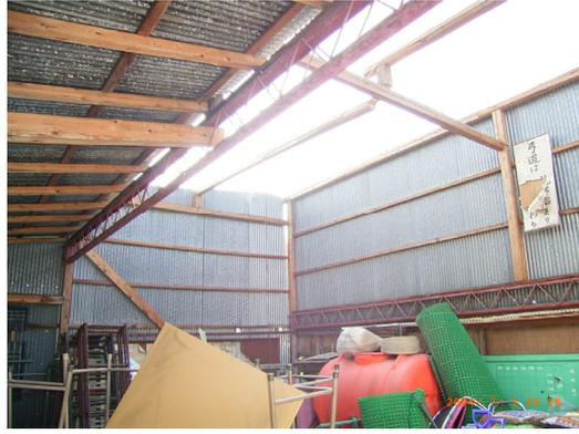
写真3 小川中学校 物置小屋の屋根飛散
